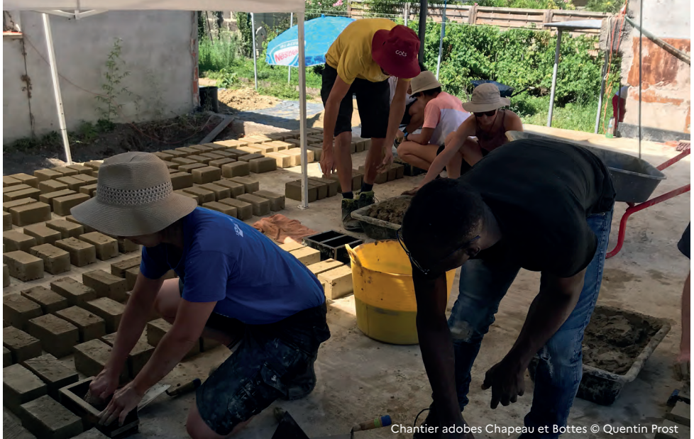
Chantier adobes Chapeau et Bottes © Quentin Prost
