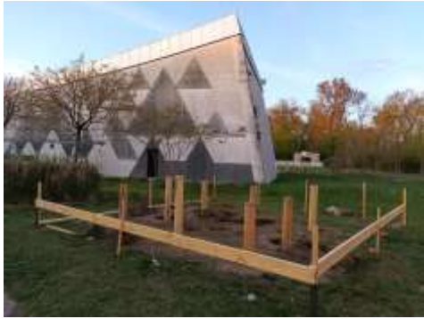
Atelier Pédagogique : construction Terre et Bois (Quentin Prost, Jean-Jacques Soulas, Géraldine Ginestet)
